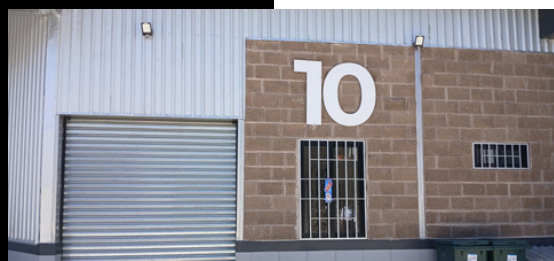
Fachada frontal de las bodegas
