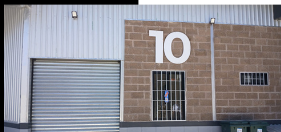
Fachada frontal de las bodegas
